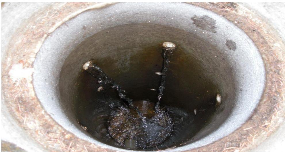
(写真5) 取水施設③ (集水管⇒ろ過槽へ移動する管が埋設されている)
