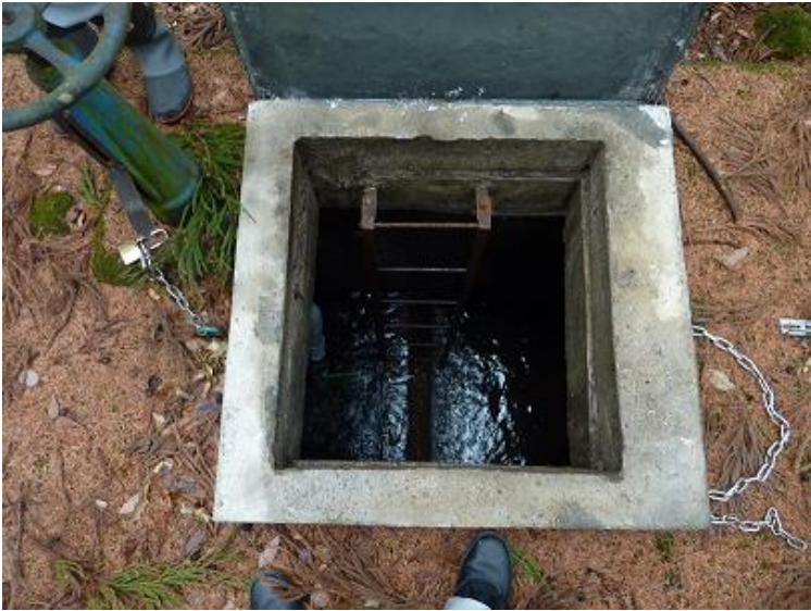
④取水施設内部
