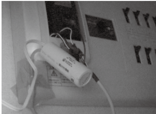
分電盤に取りつけた電力センサ
