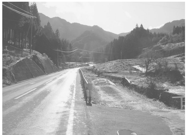
水系影響の調査実施地域（長野市）
