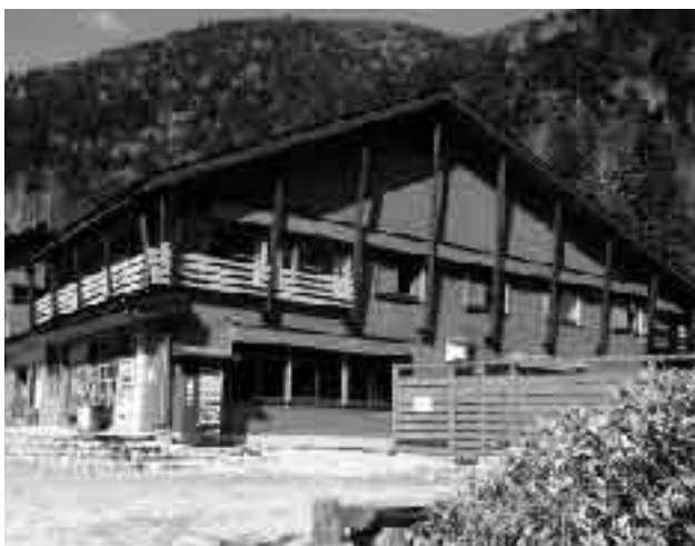
山岳地域対応のし尿処理施設をもつ山小屋(標高1620m地点)
