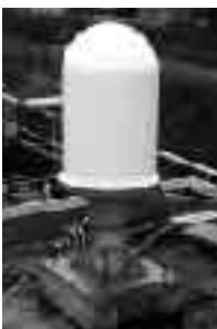
屋上の検出部
