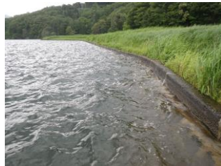
古海用水流入口 H25.7.3撮影 (魚の侵入を防止する柵なし)
