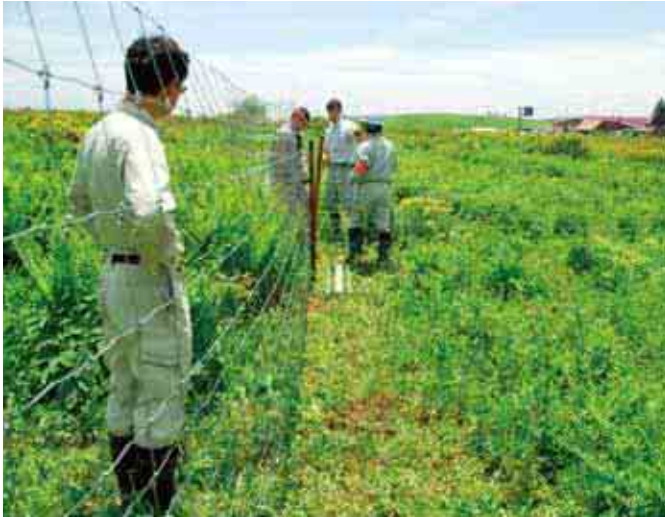
シカ防除柵の設置（霧ヶ峰）
