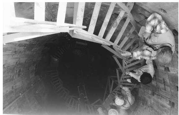
地すべり対策の集水井戸の中へ
