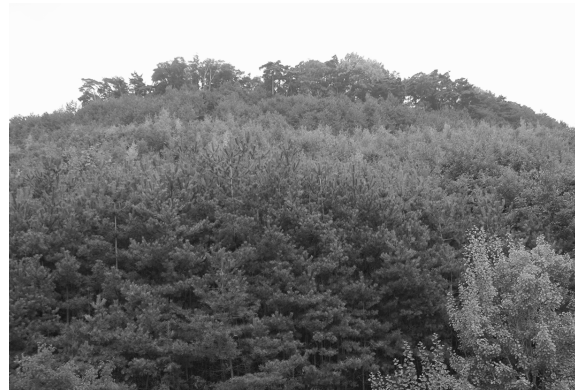
滑落崖の様子(新旧の植生の違い)
