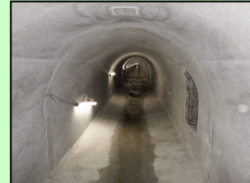
※黒川地区 鷹岩水路トンネル（伊那市）
