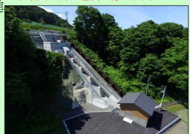
※春富水力発電所（伊那市）
