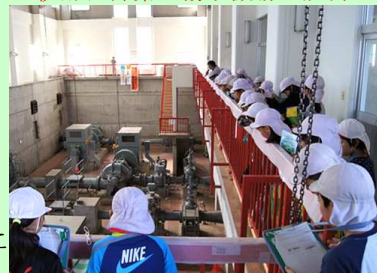
※伊那西部第1揚水機場の説明
