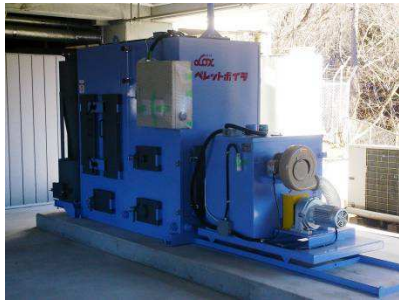
ペレットボイラー
