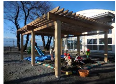
松本短大幼稚園(松本市) 砂場の日除けのためのパーゴラ
