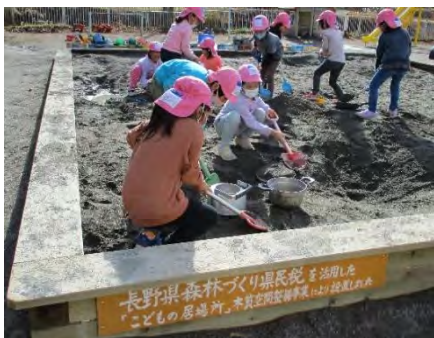
原村保育園(原村) 砂場囲いの設置
