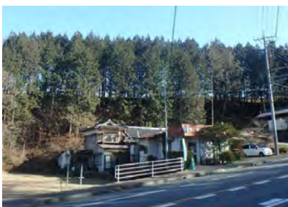
○防災・減災のための森林整備 (集落上部の間伐)
