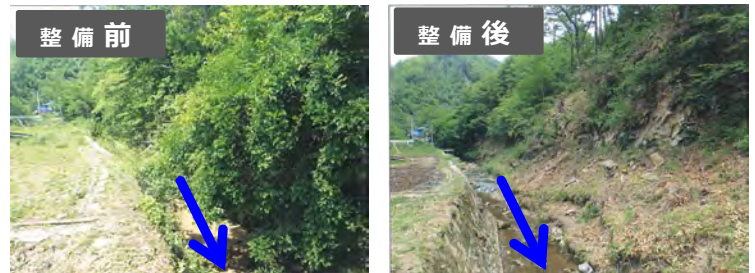
県管理河川の除間伐（一級河川 潮沢川）
