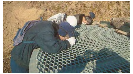
【地すべり防止施設点検状況】
