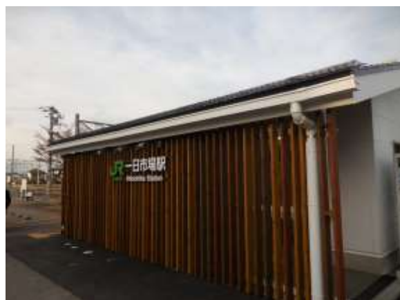
< 認証事例 > 公共建築物 (安曇野市 JR大糸線 一日市場駅) 県産材使用量 9.92 m 3 CO 2 固定量 7.0 t-CO 2
