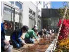
ウッドデッキ作り (茅野市)
