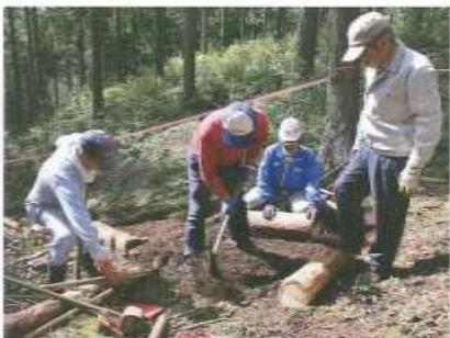
定礎の際、急斜面に間伐材を運び、1本ずつ杭で打ちつけて階段を作る
