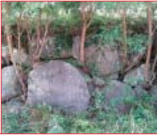
石積みによる堤防
