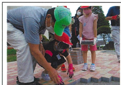
【庭園環境整備の様子】
