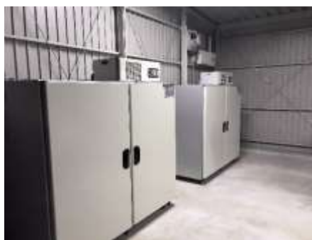
【冷蔵庫設置後の様子】
