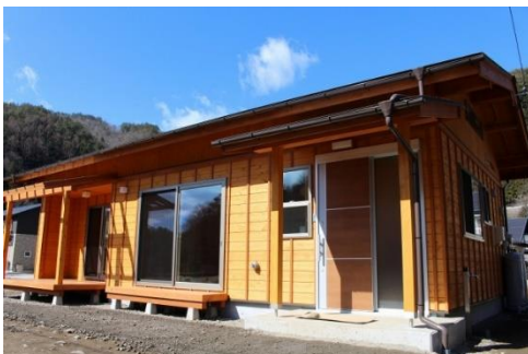
二地域居住モデルハウスの外観（県内事例）
