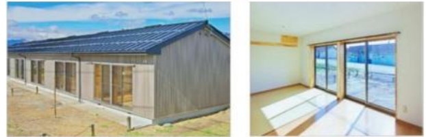
リニューアルによる長寿命化と居住環境の改善
