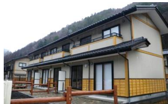
長野県産材を活用した公共施設(木曾町営住宅)
