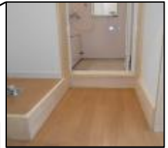
洗濯機置場 ユニットバス設置
