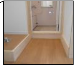
洗濯機置場 ユニットバス設置
