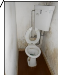
設備の老朽化
