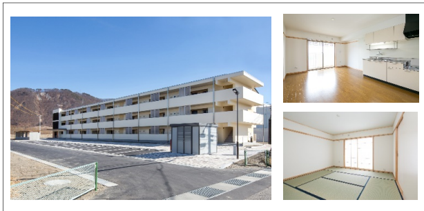
《アルプス団地(安曇野市) 3号棟 (H30.2月完成)》
