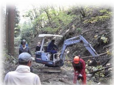
作業道の補修
