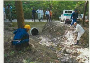
② 土砂撤去後【設置個所の寸法計測】
