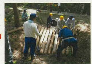
③ 作業中（丸太は現地の間伐材を再利用）
