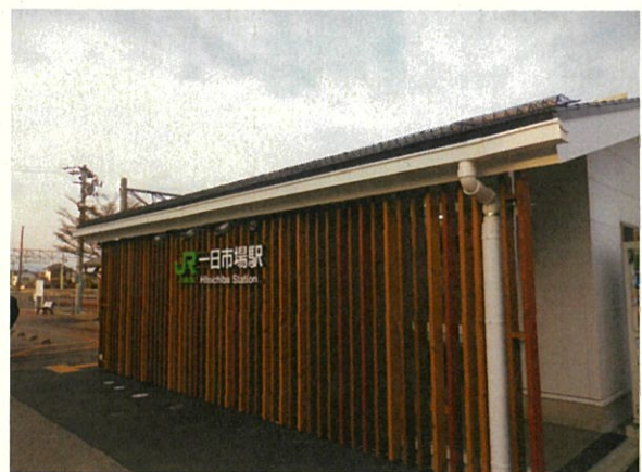
< 認証事例 > 公共建築物 (安曇野市 JR大系線 一日市場駅) 県産材使用量 9.92 m 3 CO 2 固定量 7.0 t-CO 2
