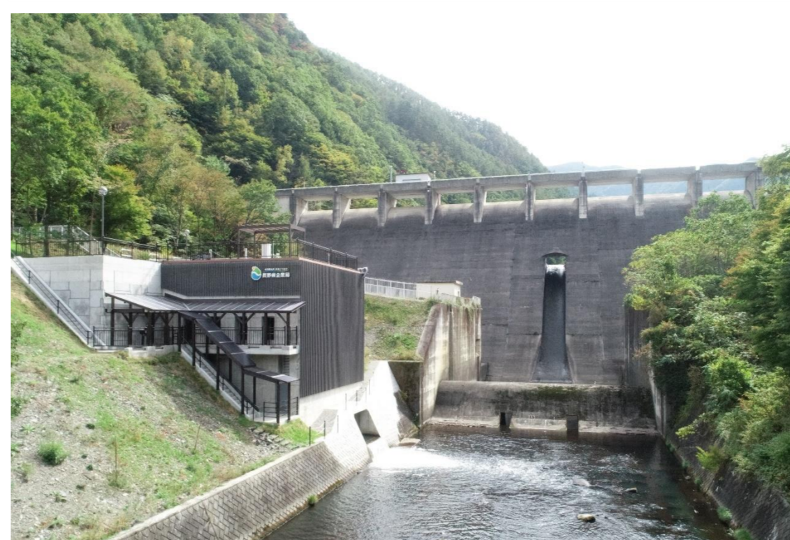
横川蛇石発電所 R2.4.1 運開 「地域連携型水力発電所」第1号として運開。
