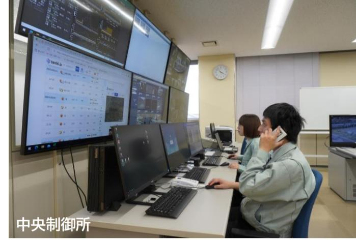
**中央制御所**では、南信・北信発電管理事務所管内の発電所の運転管理や発電水量の調整などの監視制御を行うとともに、災害にも強い次世代監視制御ネットワークを構築し、発電施設の保安の高度化やスマート化を進めています。また、AI等を用いた流入量予測システムの構築や、各種データの分析等による故障等の予防保全にも取り組んでいます。長野県の資産である発電施設で、最大限の利益を生み出し、多くの利益を県民へ還元するため、最新のICT技術を用いた効果的な運転管理に努めています。
