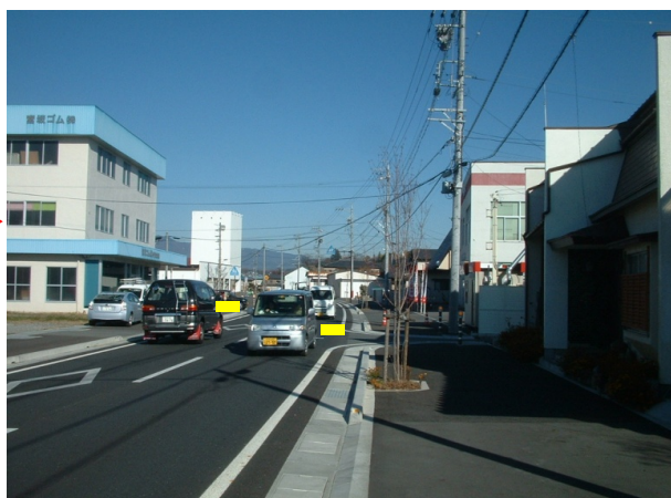
事業後(車道広い:歩道あり)
