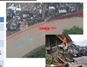
河岸侵食に伴う家屋倒壊
