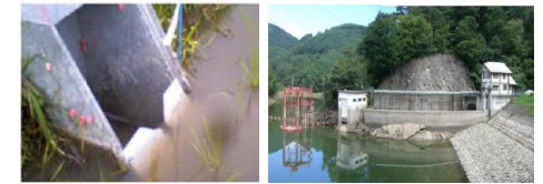
水田排水口の調整装置設置例 ため池の低水位管理実施例
