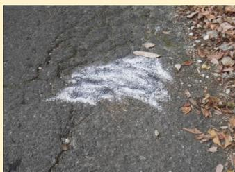
④最後に、後続車のタイヤに補修材が付着しないように防止剤をかけて補修完了です。
