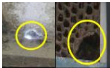
壁や金網の破損修繕
