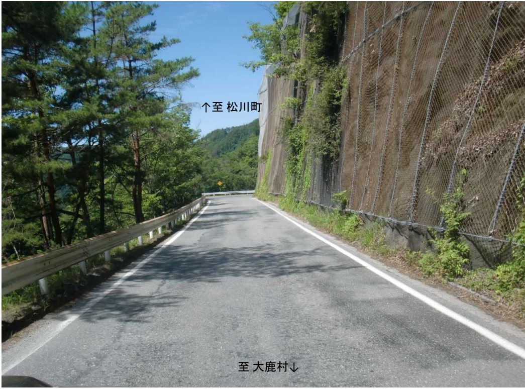
工事前 道路状況 (大鹿村側から松川町方面を望む)
