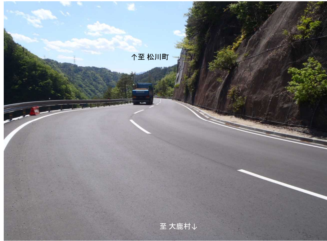
工事後 道路状況 (大鹿村側から松川町方面を望む)
