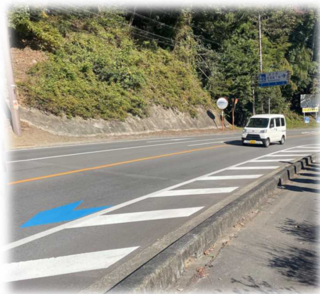
↑国道151号の矢羽根型路面標示 (写真左下の青い矢印マーク)
