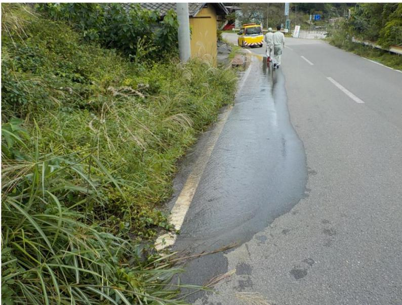
①道路側溝が泥などで詰まり、水が漏れ出している状態です。
