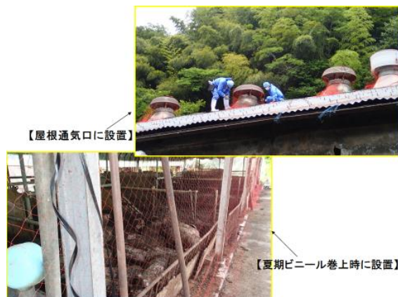
写真1 防鳥ネット設置・施工の様子
