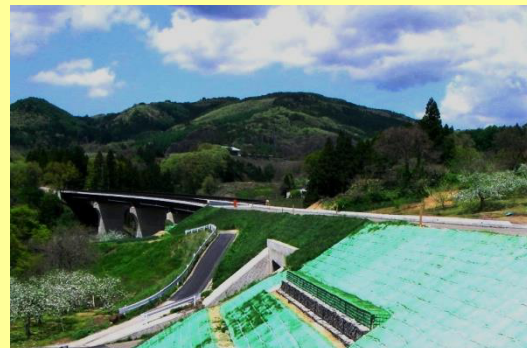
整備が進む「替佐～静間バイパス」
