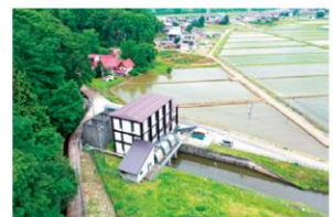
【湛水被害から農村を守る木島第一排水機場】
