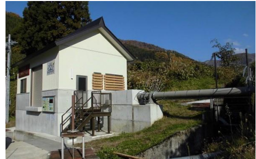
小水力発電所（野沢温泉村）
