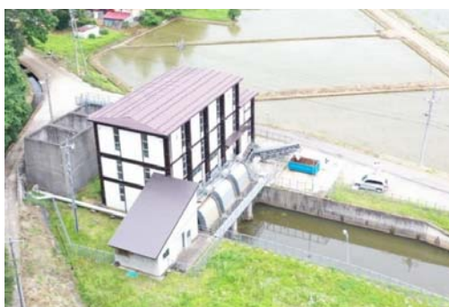
湛水被害を防止する排水機場(木島地区)
