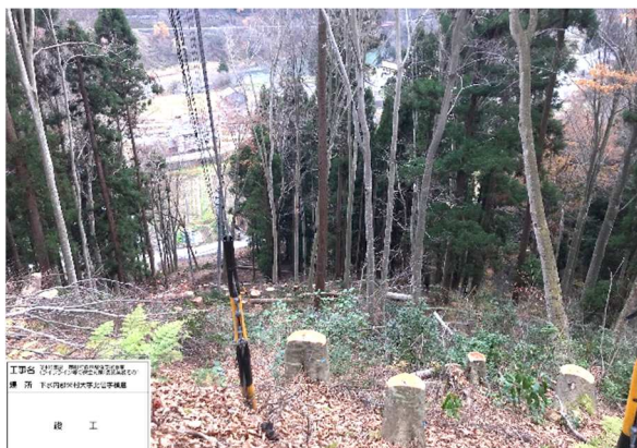
整備後（電線沿いを一定幅で伐採）
