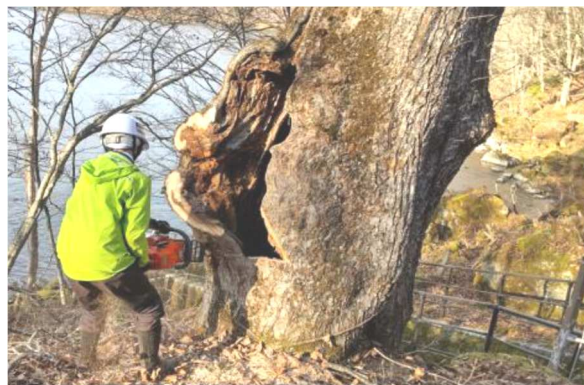
巨木の伐採作業
