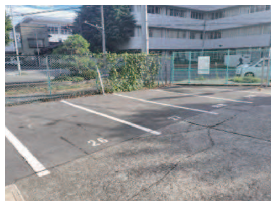
▲施工前（アスファルト舗装）
