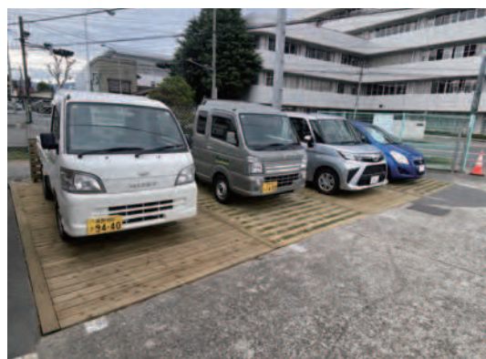
▲施工後（木製舗装）
