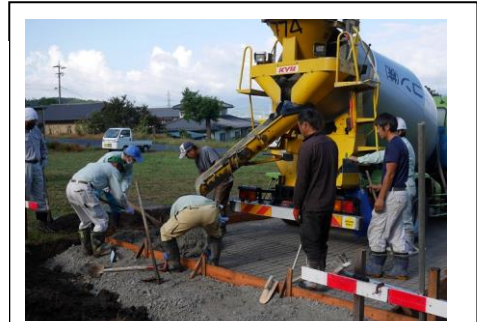
【農道舗装の様子】
