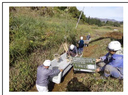
【U字溝布設状況】
