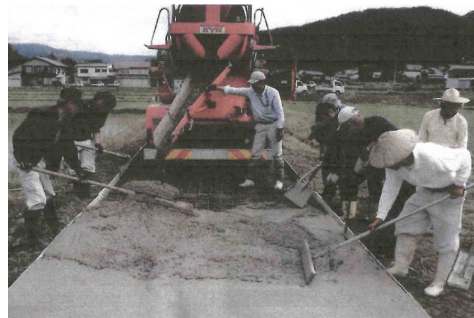
【農道の舗装作業】
