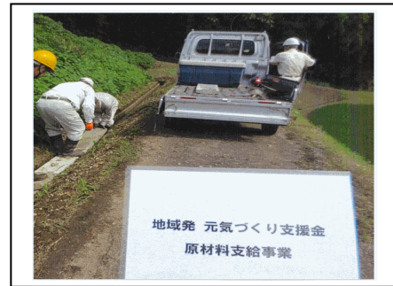
【溝蓋布設状況】
