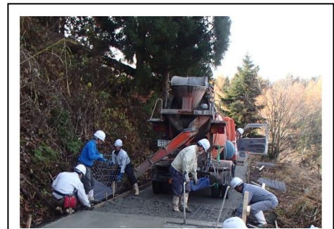
【住民による林道舗装事業の状況】
