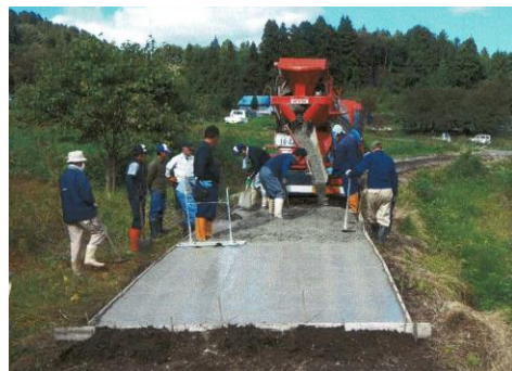
【農道の舗装作業】
