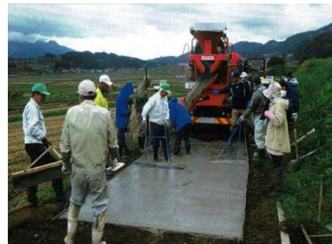
【農道の舗装作業】
